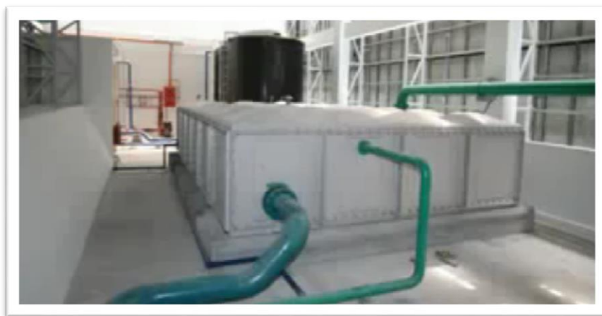
Gambar 2.59: Tangki penuaian air hujan di bangunan GEO, presint 9 Bandar Baru Bangi
