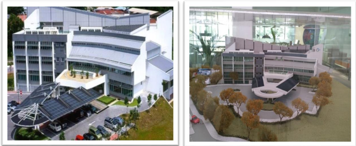
Gambar 2.58: Bangunan Rendah Karbon di Seksyen 9, Bandar Baru Bangi
