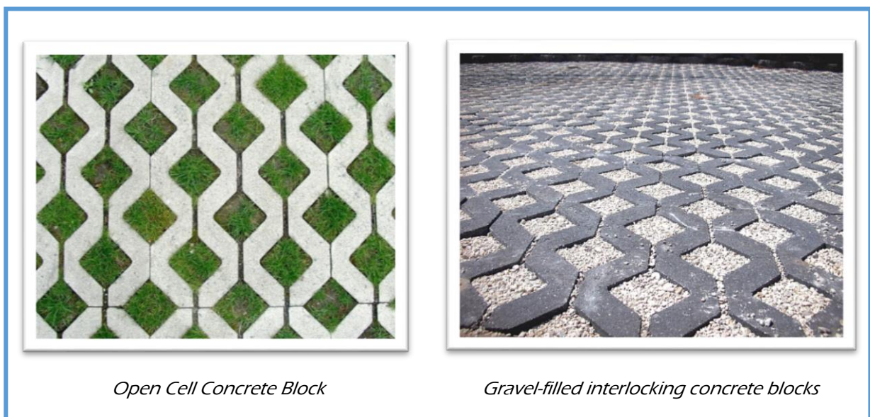
Gambar 2.53: Contoh Turapan Telap Air yang Mesra Alam
